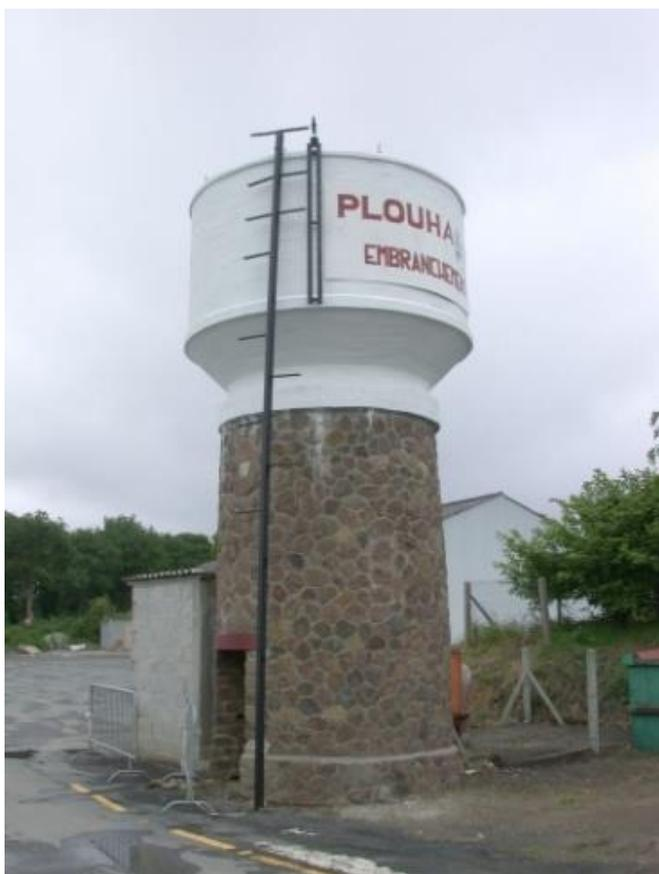
Figure 50 : Pour épancher la soif des locomotives à vapeur, qui consommaient plusieurs dizaines de litres d'eau par kilomètre, les gares étaient équipées de châteaux d'eau comme ici en gare de Plouha (source : patrimoine.bzh, auteur : Patrick Pichouron, 2005)
